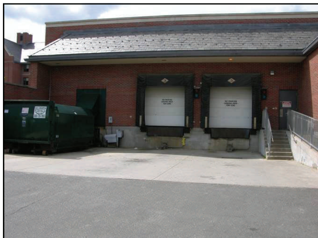
Rome Commons Loading Dock.
